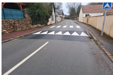
Mise aux normes du dos d'âne
