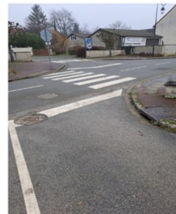
Réfection de la signalisation
